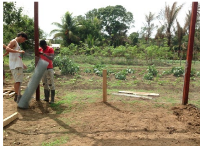
Afbeelding 27. Kelvin en David installeren het kippengaas
