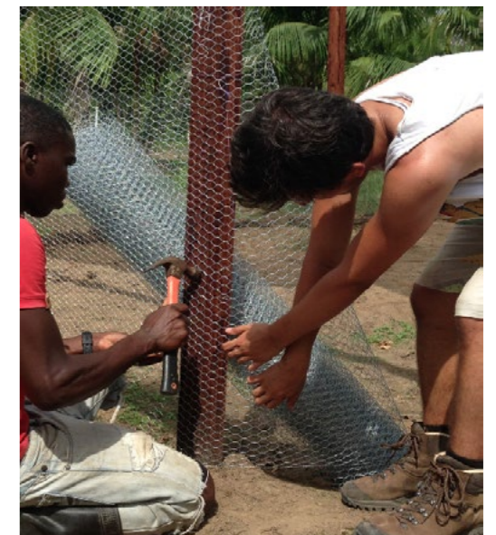
afbeelding 30: kippengaas rechtekken
