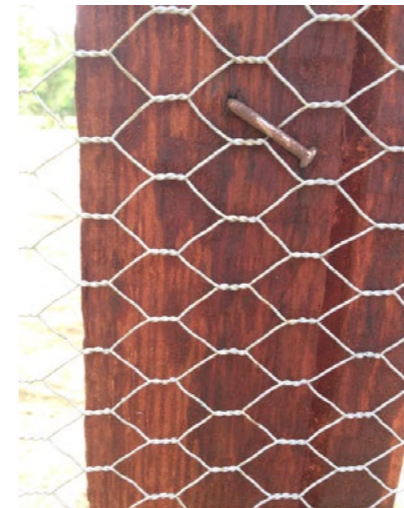
afbeelding29:kippengaasbevestigen
