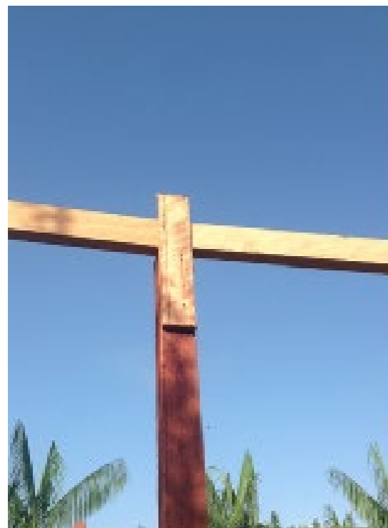
afbeelding 13: verbindingsstuk dakpaal
