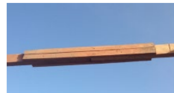
afbeelding 8: Gronfolo ligger met verbindingstuk
