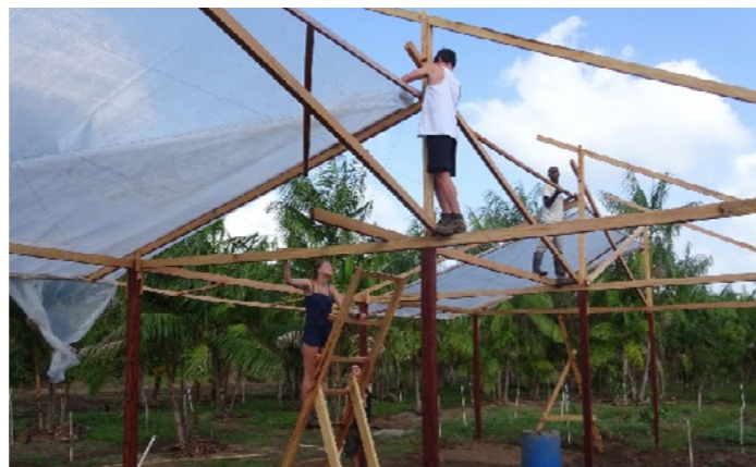
Afbeelding 21. David en Heleen zijn bezig met het bevestigen van het plastic
