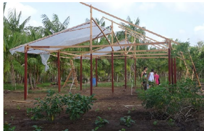
Afbeelding 20. De kas waarbij het plastic op twee dakblokken bij de lage kant is bevestigd
