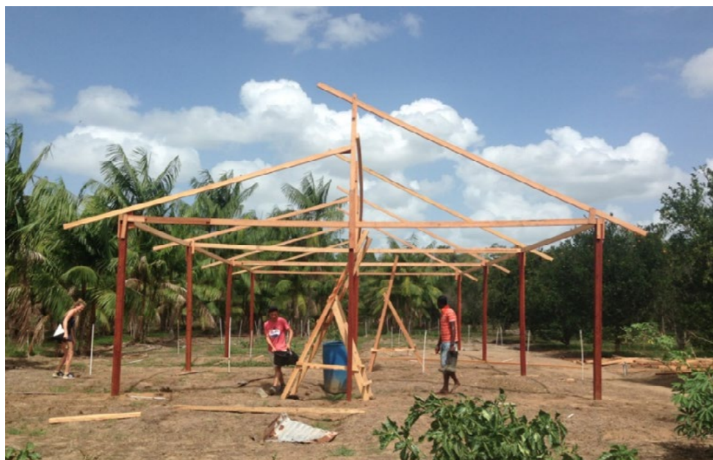
Afbeelding 10. De constructie van de kas, van Gronfolo en Walaba-hout
