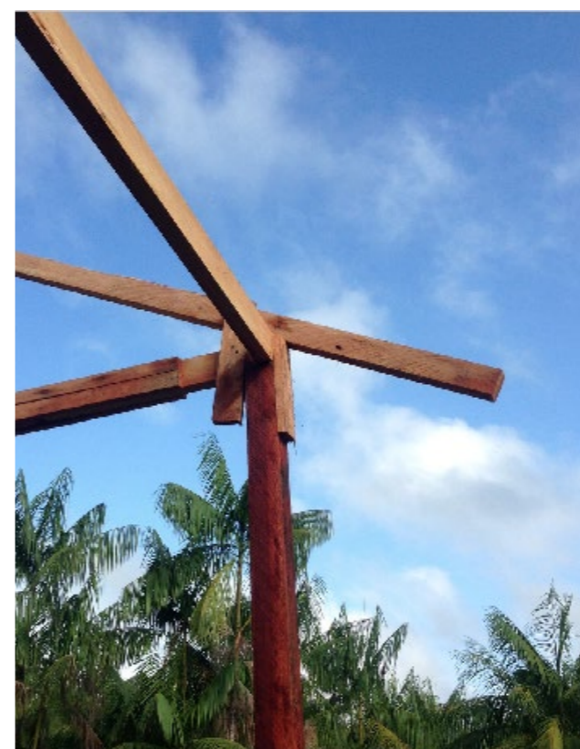
afbeelding 16: Schuine lat lage kant bevestigen
