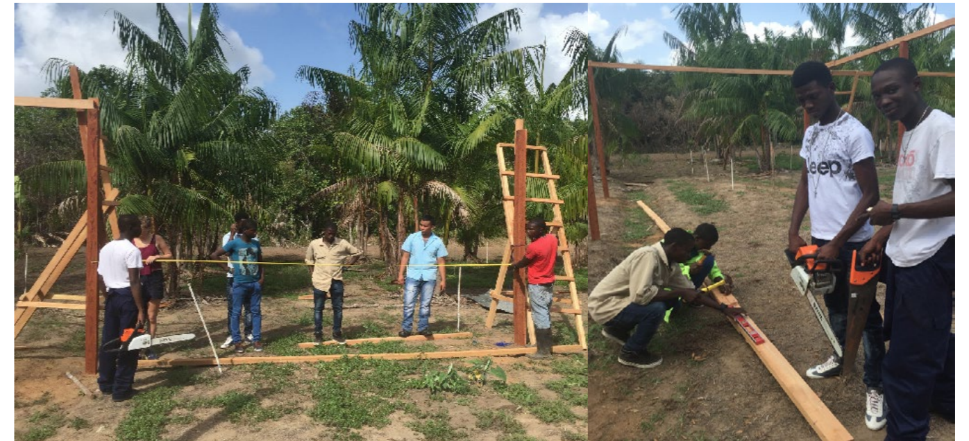
Afbeelding 3. Barronschool leerlingen meten de benodigde lengte voor de ligger
