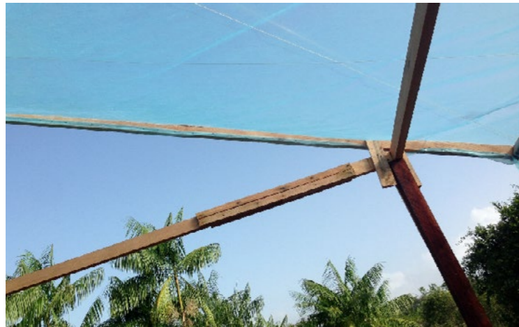
afbeelding 24: plastic zijkant bevestigen
